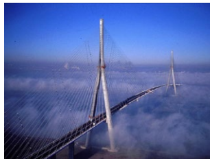
Pont de Normandie, France
