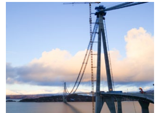
Hålogaland Bridge, Norway
